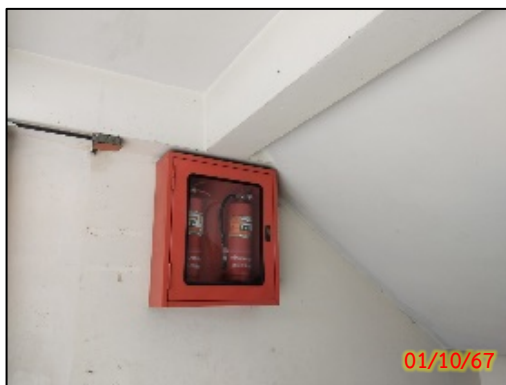
รูปที่ 2.2-11 ดับเพลิงแบบมือถือชนิดผงเคมีแห้ง
